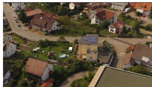
St. Margareten-Straße mit Bahnübergang Quelle: Auftraggeber
